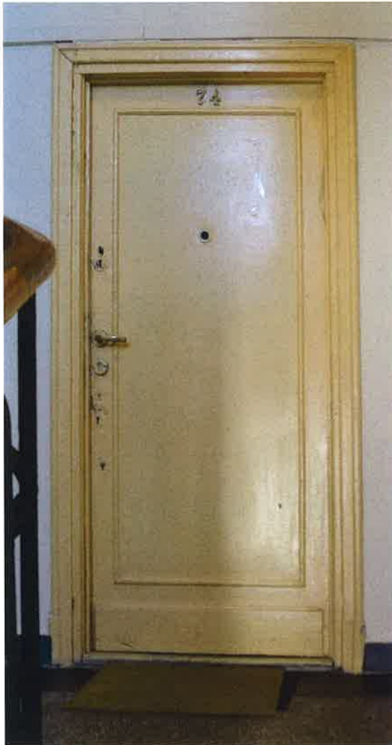
II. 98 Oryginalne drzwi wejściowe do lokalu mieszkalnego z profilowanymi odrzwiami
