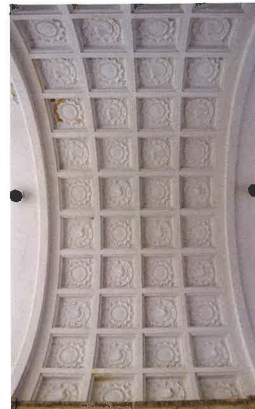
Il. 73 Łącznik południowy, widok na środkowe przęsło z pomalowanymi na biało kasetonami ceramicznymi
