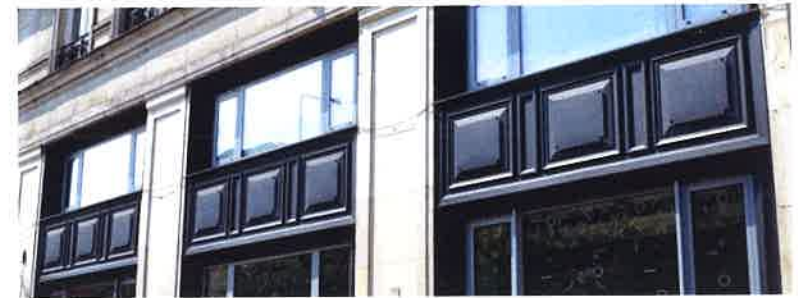
II. 113 Odtworzone płyciny miedzy witrynami parteru i antresoli w d. barze mięsny - bibliotece
