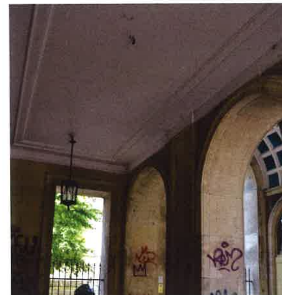
II. 78 Boczne (południowe) przęsto łącznika północnego o płaskim sklepieniu
