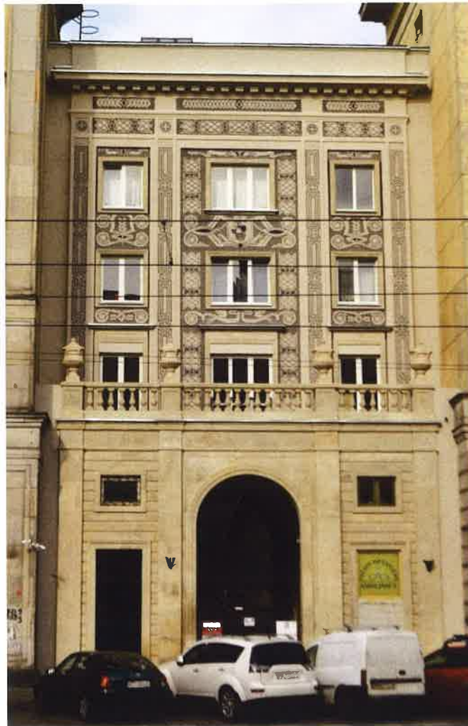
II. 64 Elewacja frontowa, łącznik północny (częściowo zabudowany)
