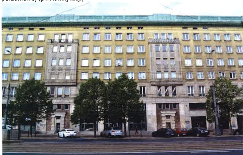
II. 41 Elewacja frontowa, widok w kierunku zachodnim, w przyziemiu wejścia do lokali, powyżej wykusze
