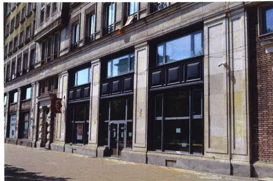
II. 44 Elewacja frontowa, witryna lokalu użytkowego – ob. biblioteki miejskiej (d. bar mięsny; „Szanghaj”)
