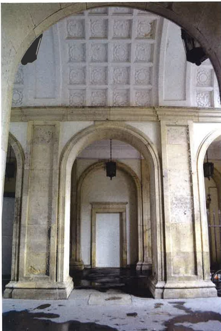
Il. 71 Łącznik południowy widok południowej nawy środkowego przęsła na ścianę północną, na wprost filary, w bocznych nawach po 3 latarnie (po jednej na środku przęsła), asfaltowy przejazd
