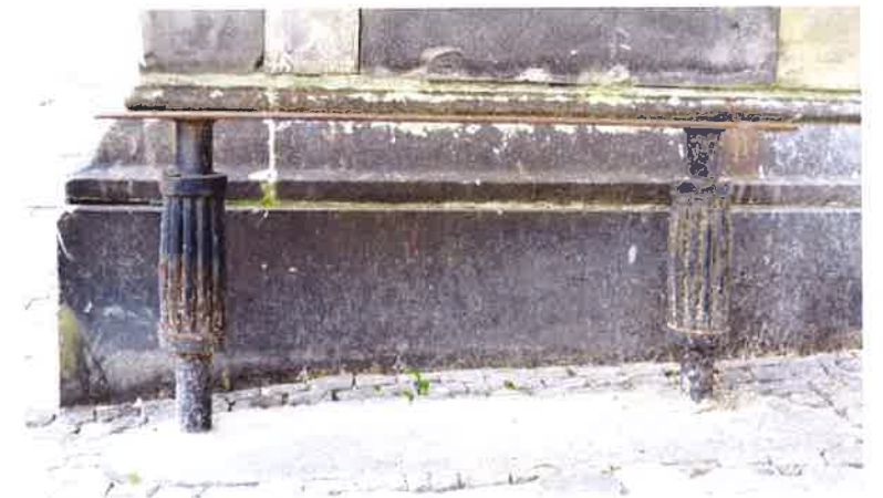
II. 114 pozostałość oryginalnej ławki przy elewacji między głównym korpusem a północnym łącznikiem
