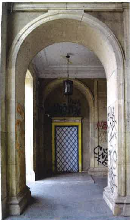
II. 74 Łącznik północny widok na ścianę południową, drzwi do lokalu
