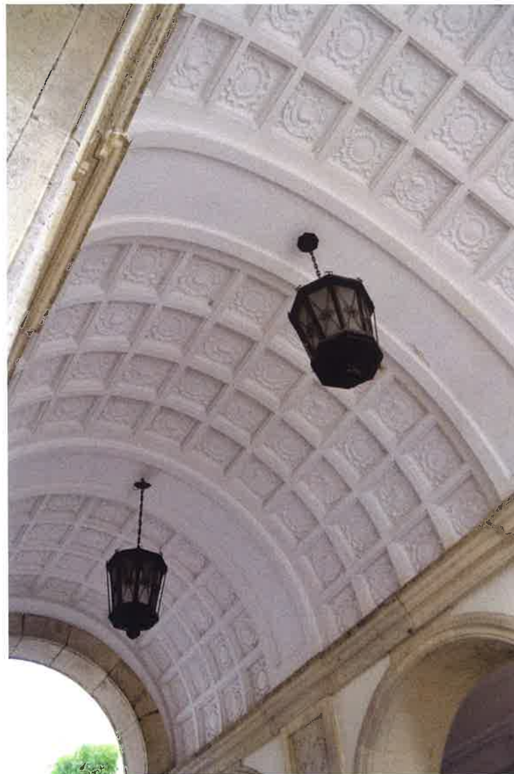
Il. 1 Łącznik południowy widok na sklepienie środkowej nawy, kasetony pomalowane na biało, na gurtach oryginalne latarnie
