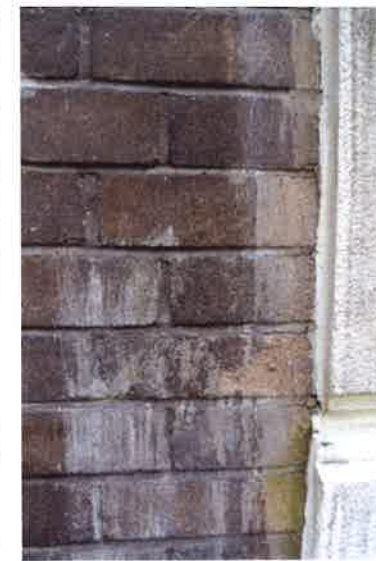
Il. 57 Detal elewacji od strony podwórka okładzina klinkierowa i opracowanie ściany w tynku
