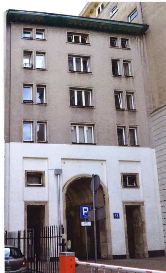
II. 65 Elewacja od strony podwórka, łącznik południowy z budką strażniczą
