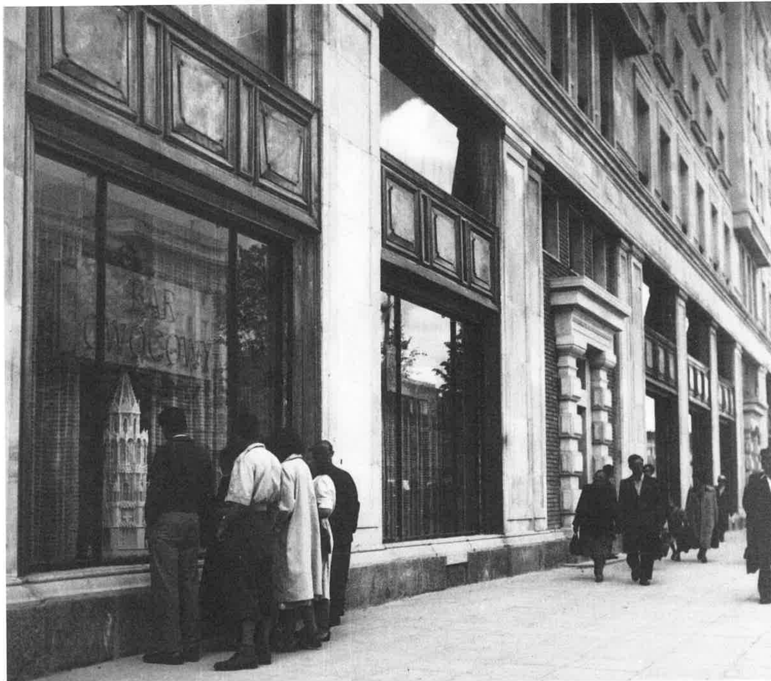
II, 15 Budynek przy ul. Marszałkowskiej 55/73, elewacja frontowa, widok witryny baru owocowego, widoczna ekspozycja, okładzina ceramiczna obokni, fot. ok. 1952, W. Piotrowski, ze zbiorów Archiwum Fotograficznego Instytutu Sztuki PAN
