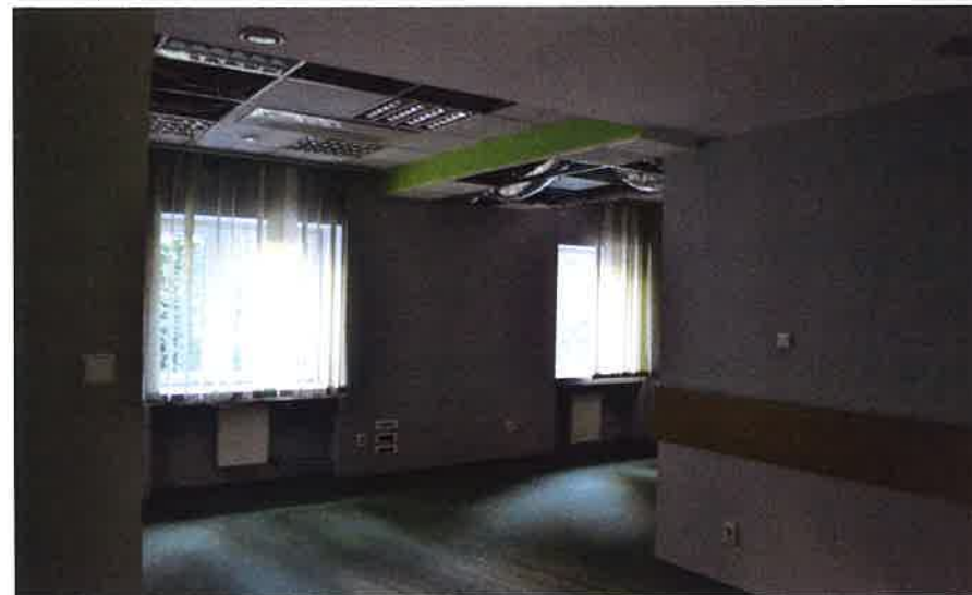
Il. 82 Wnętrze d. baru owocowego, antresola z podwieszonym sufitem, pozbawiona historycznego wystroju
