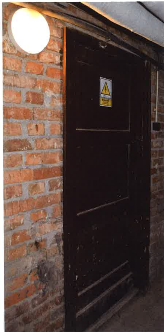
II. 102 Drzwi wejściowe do komórki piwnicznej
