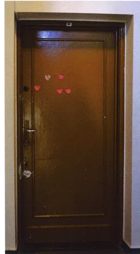
II. 100 Oryginalne drzwi wejściowe do lokalu
