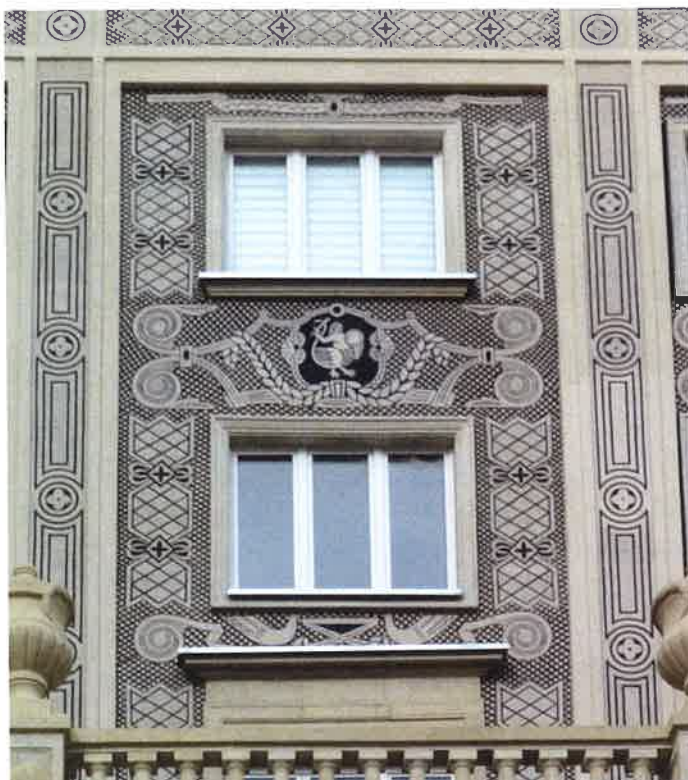
II. 66 Łącznik południowy, dekoracja sgraffitowa z motywem półkobiety, półptaka (historyczny herb m. Warszawy)
