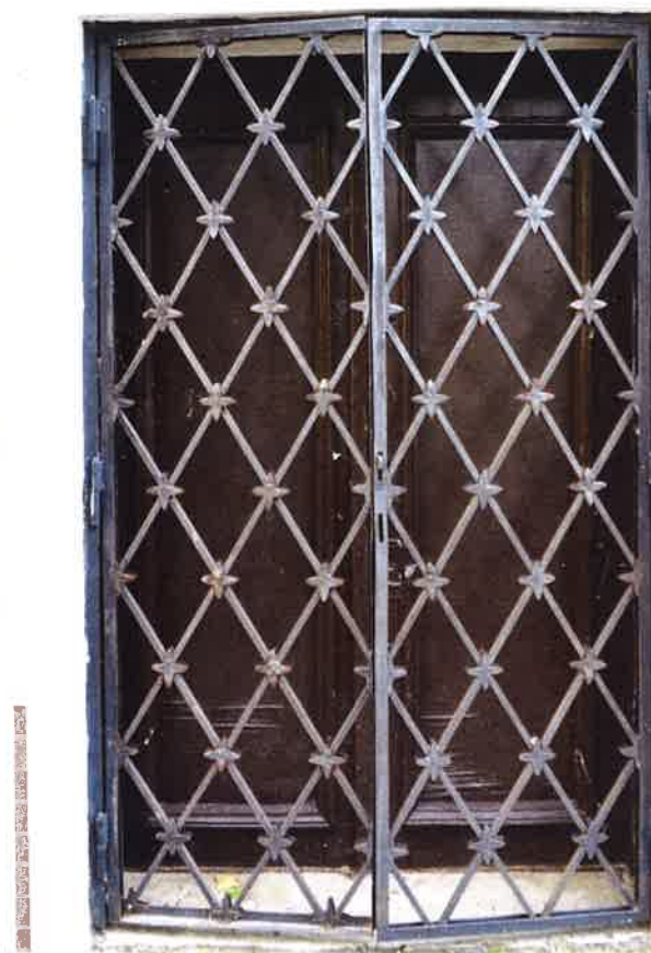
II. 62 Oryginalna 2-skrzydłowa stolarka z pojedynczą płyciną (d. lokal baru rybnego), zachowana oryginalna kratka dwuskrzydłowa
