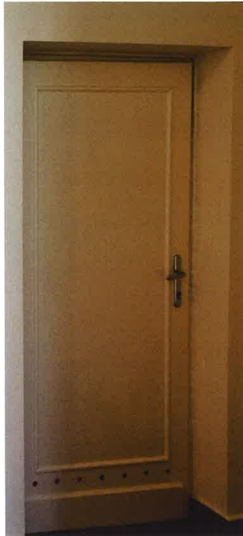
II. 99 Oryginalne drzwi do pomieszczenia technicznego
