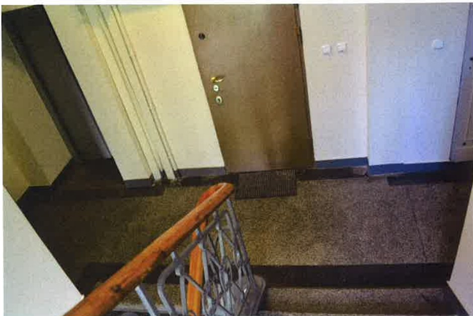
II. 92 Wnętrze klatki schodowej, posadzka z lastryko na piętrze
