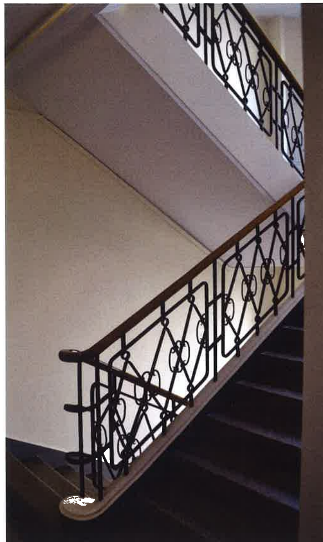
II, 90 Wnętrze klatki schodowej, piętro
