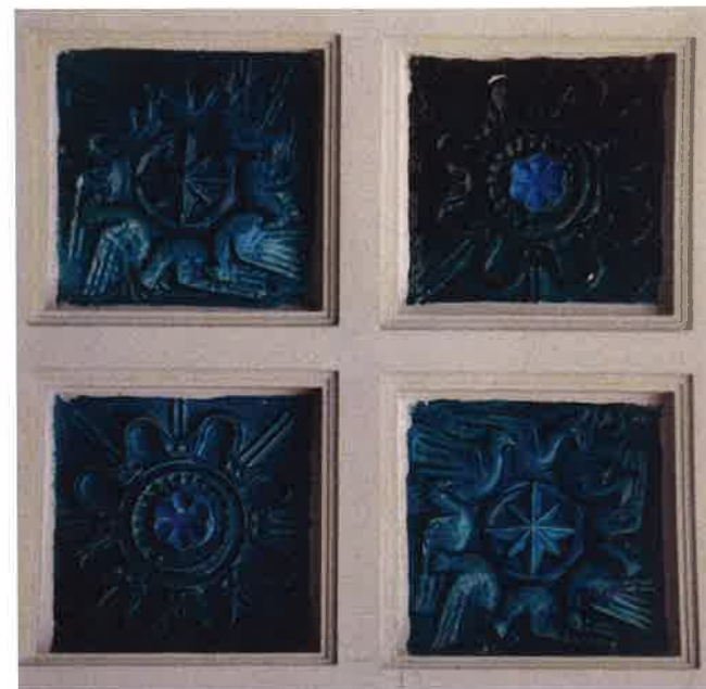
II. 77 Ceramiczne kasetony szklwione na kolor turkusowy, zróżnicowanie barwne wynika z charakteru szkliwa; 2 typy płytek
