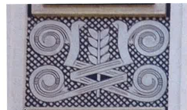
II. 70 Sgraffitowa dekoracja płycin podokiennych północnego łącznika
