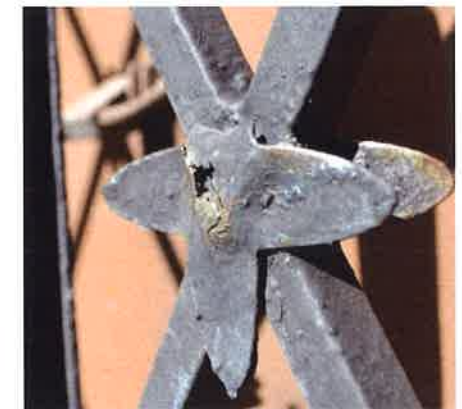
II. 107-108 Detal stałej kraty okiennej od strony podwórka
