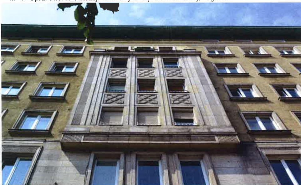
II. 49 Wykusze elewacji frontowej z dekoracyjnie opracowaną okładziną kamienną z piaskowca
