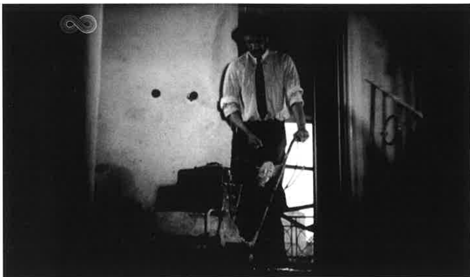
II. 32 Przykładowe wnętrze klatki schodowej na MDM w trakcie prac, kadr z PKF 31/51, 00:00:00:12, FilMOTEKA Narodowa
