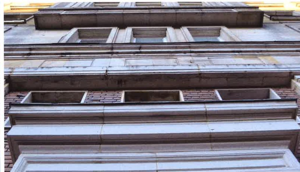
II. 50 Kamienne opracowanie elewacji frontowej w osi wykusza, od dołu widoczny portal, trzecia kondygnacja, podniebienie wykusza
